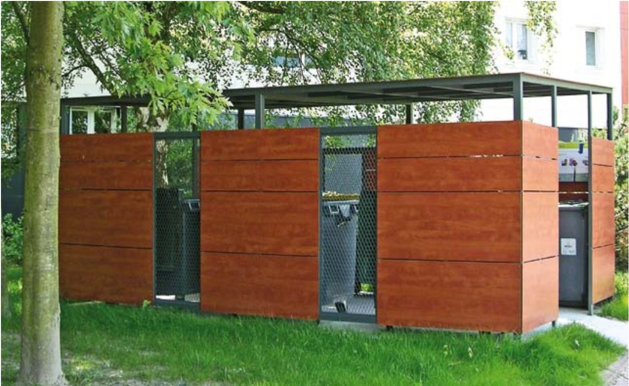
Project __Local Poubelle „Résidence l'Abbaye“ St Cyr Ecole Country __France Design __Tectum Decor __0601 NT
